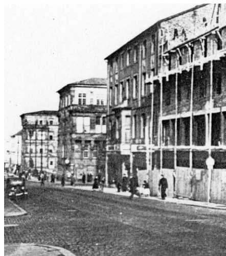
Nach erster Beseitigung der Kriegsschäden
